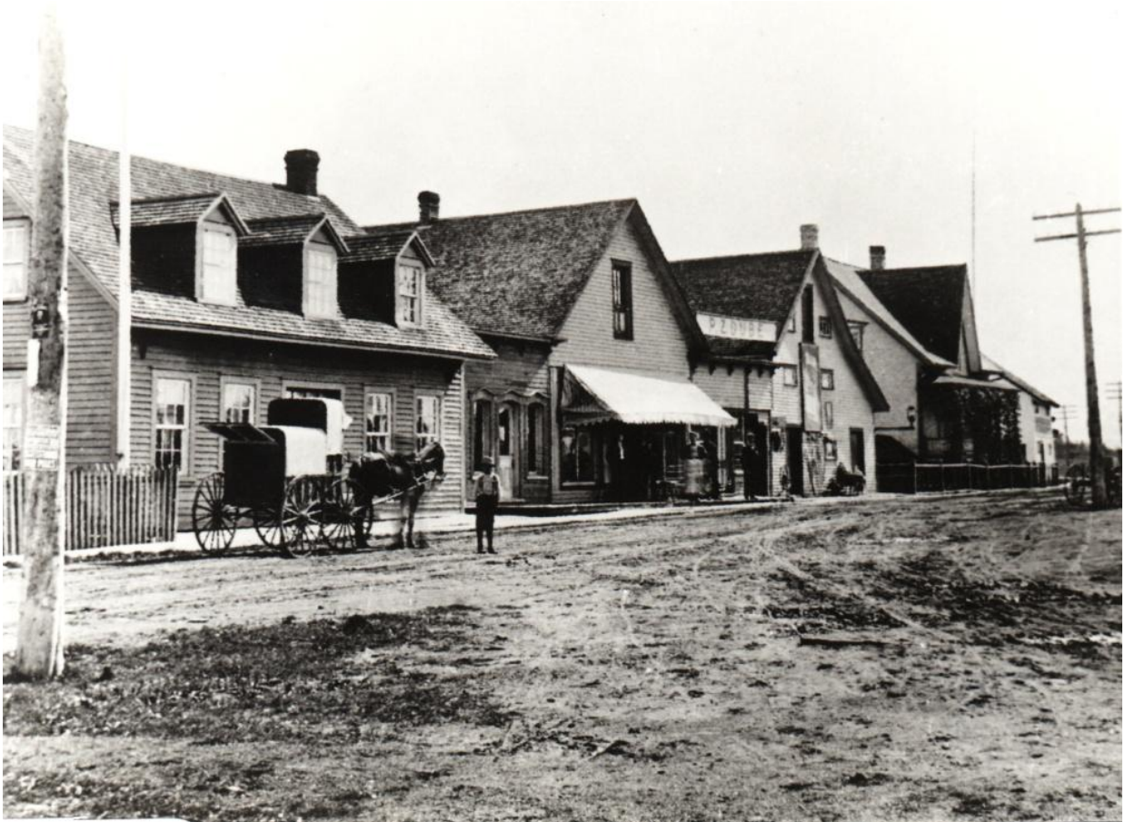
Photo: au centre, magasin et entrepôt de P.Z. Dubé, vers 1915.
